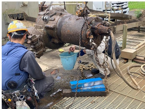
No. 3 水中ポンプ引き上げ調査
