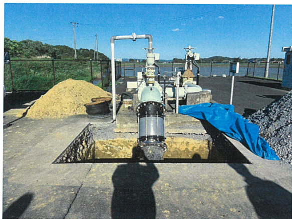
配管(可とう管) 応急復旧
