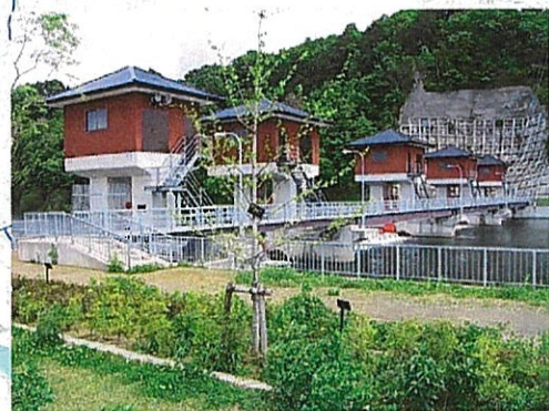
① 伊豆野頭首工
