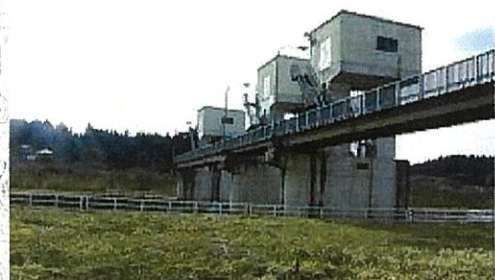
②板倉頭首工
