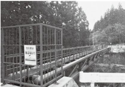
皿亀川水管橋塗装整備補修
