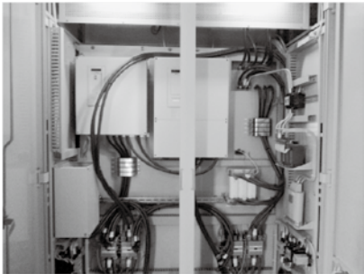
内の目揚水機場 (登米市石越町地内)
