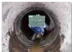
幹線用水路パイプライン漏水補修
