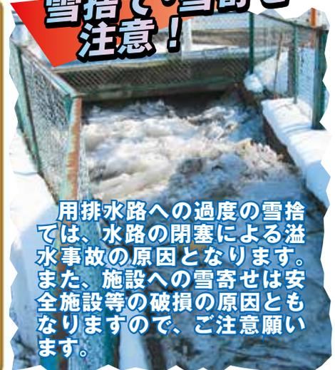
用排水路への過度の雪捨ては、水路の閉塞による溢水事故の原因となります。また、施設への雪寄せは安全施設等の破損の原因ともなりますので、ご注意願います。
