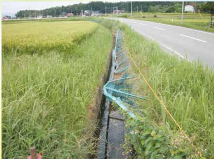
左記写真は、栗駒稲屋敷を通っている県営一の堰用水路の末端付近で、トラックが水路脇の転倒防止のために設置したフェンスに、路肩をはみ出し倒したときの状況です。
