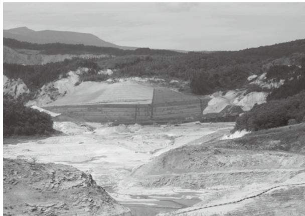
【土砂を撤去し法面を補強したダム】
