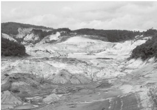
【地震で崩れ土砂が流入したダム】
