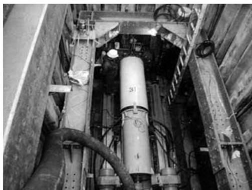
【掘削・管押込み状況】
