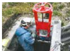
取水ゲート補修
