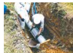
パイプライン補修
