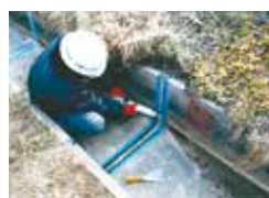
用水路目地補修
